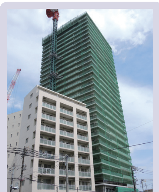
建設が進む新綱島駅直上のタワーマンション
